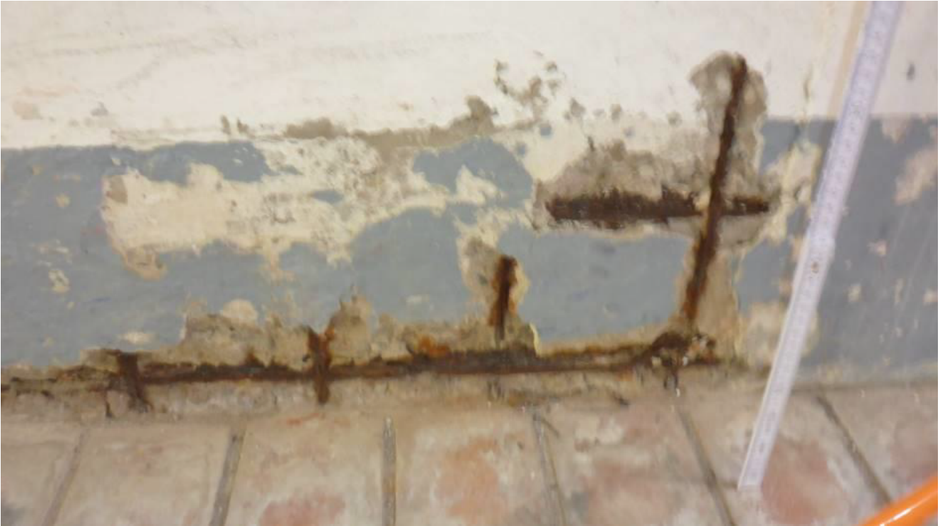
Korrosion an der Decke des Beckenumlaufes
