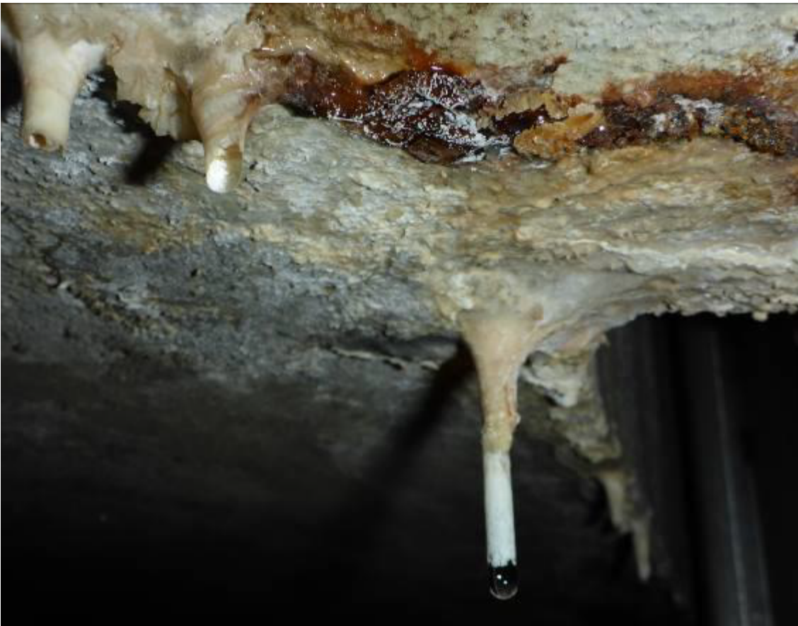
Korrosion an der Decke des Beckenumlaufes
